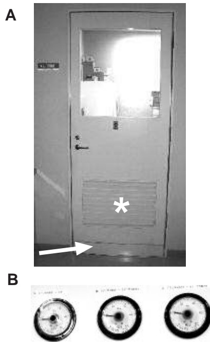
図4 (A) 実験室の扉。外開きとする。P2 実験室では室内は負圧にしないが、P3 と P2 実験室の扉が逆向きに開くのは不便である。扉の下には 100 mm の羽目板がある。履き物の処理、粉塵混入の防御などに有効 (矢印)。前室から見た P3 実験室の扉には、ガラリを切っており、扉が閉まっているときにも一方向気流を確保する。扉を開けたときに生じる気流の攪乱を少なくすることができる。前室の排気はすべて実験室に流すことで空調を簡単にすることができる。(B) P3 実験室の気圧監視装置。
