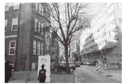
BSL-4施設 (新館) ベルンハルト・ノホト熱帯医学研究所 ホテルやマンションと隣接して建つ
