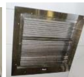
換気口部分の 侵入防止対策
