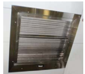
換気口部分の侵入防止対策
