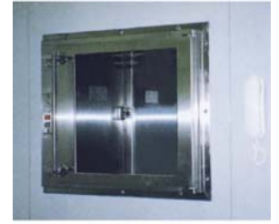
パスボックスの写真
