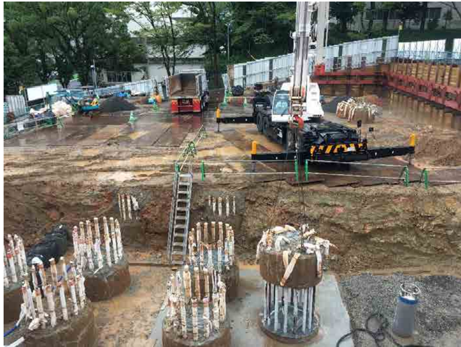
杭上部コンクリート撤去状況（9/2撮影）
