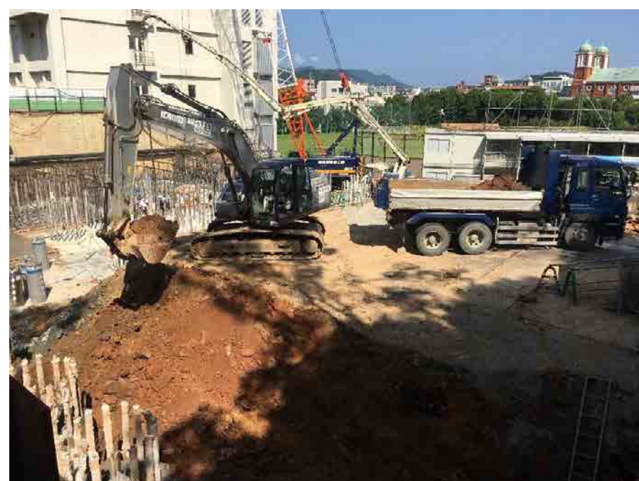
掘削状況（9/17撮影）
