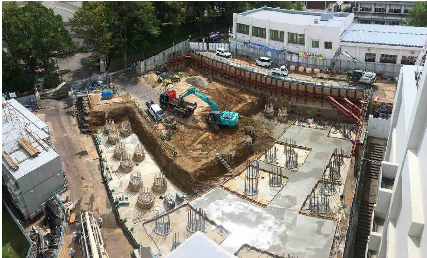
施工状況全景（9/5撮影）
