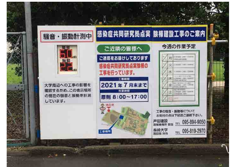
北側フェンス状況（8/29設置）
