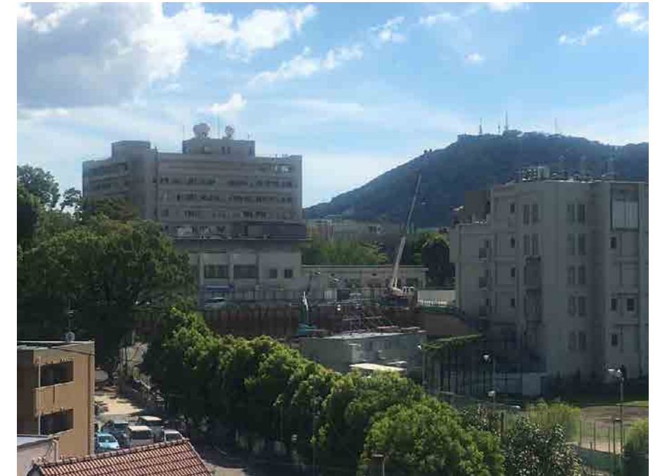
施工状況全景（9/5撮影）
