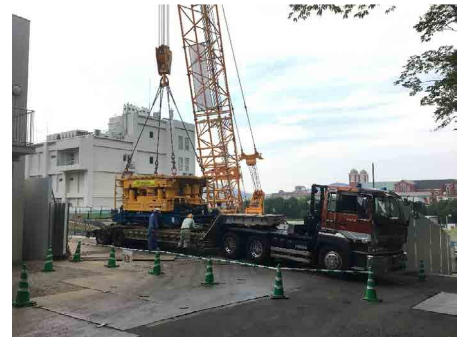
杭重機搬出状況（8/5撮影）
