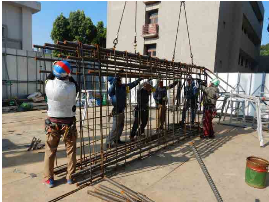
鉄筋組立て状況（9/14撮影）
