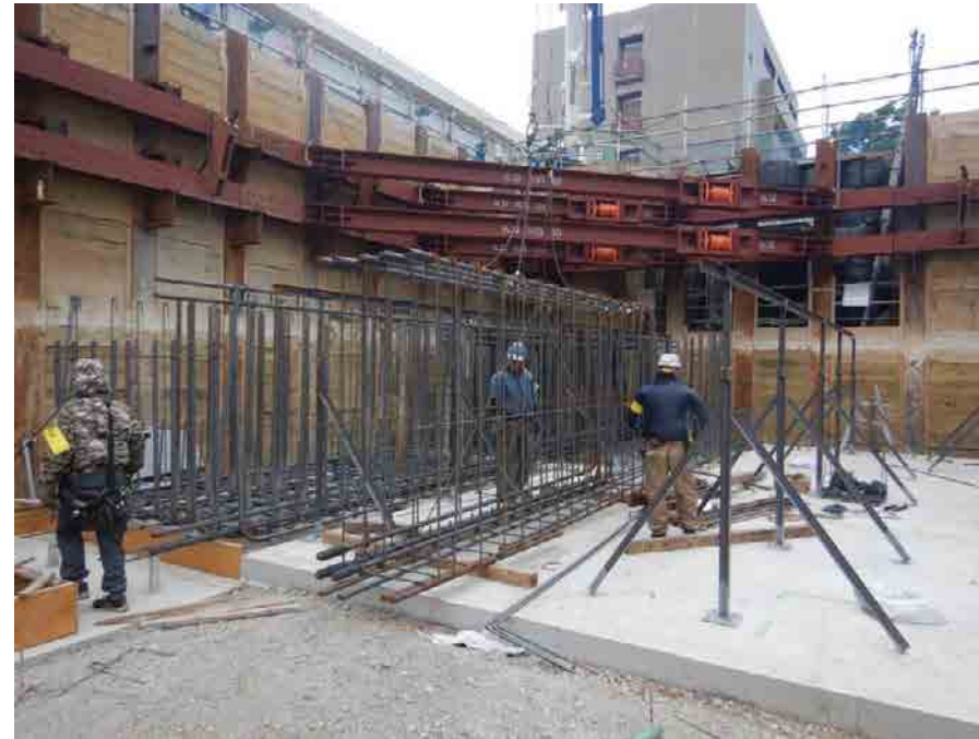
鉄筋組立て状況（9/14撮影）
