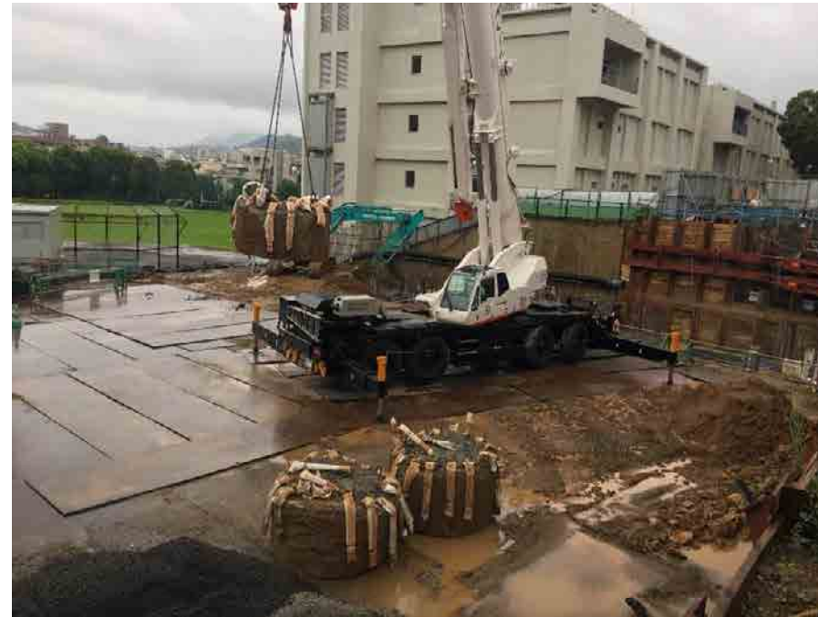
杭上部コンクリート撤去状況（9/2撮影）
