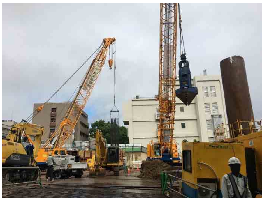
掘削・鉄筋かご設置状況（7/1撮影）
