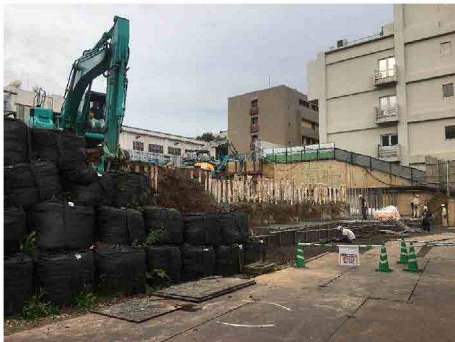
掘削状況（9/3撮影）
