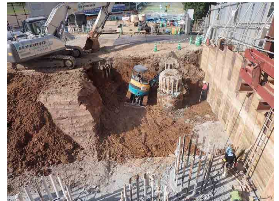
積込・搬出状況（9/17撮影）
