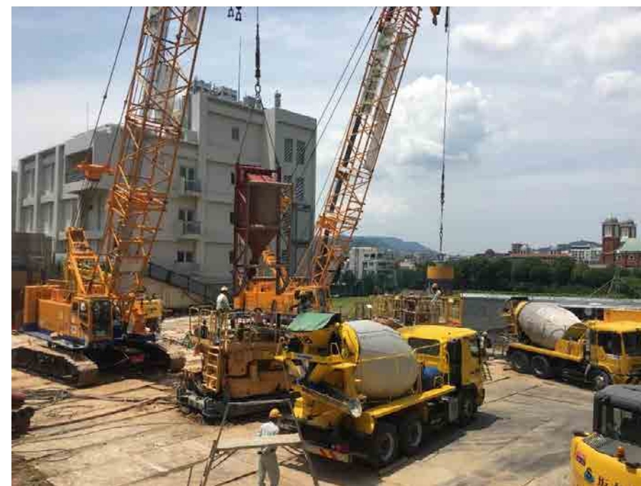
コンクリート打設状況（7/1撮影）
