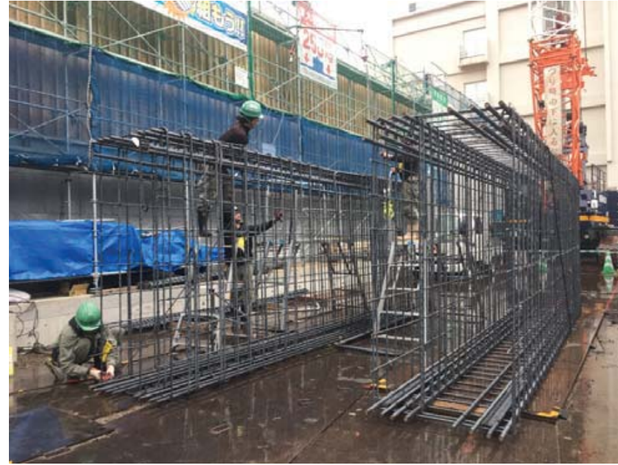
1階床梁鉄筋組立状況（12/24撮影）
