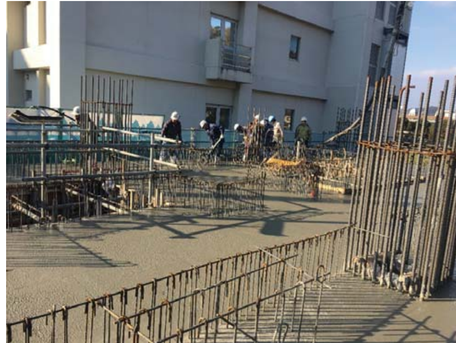
コンクリート打設状況（12/28撮影）
