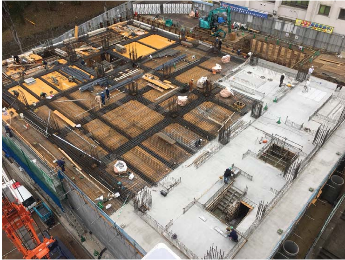
施工状況全景（1/6撮影）
