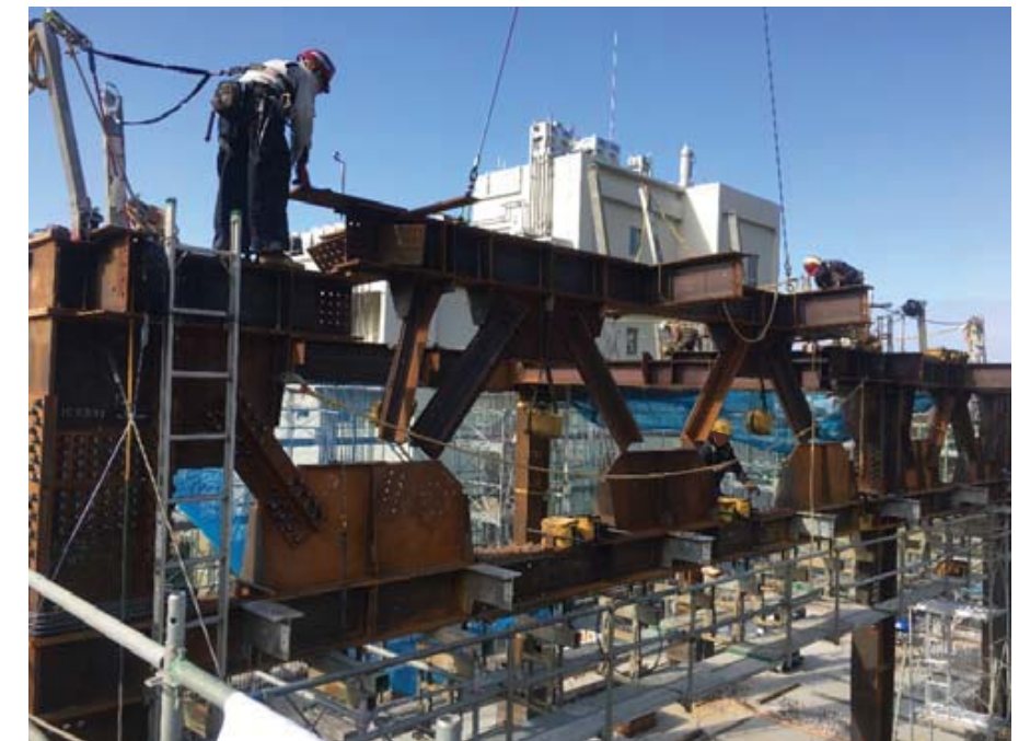
鉄骨工事施工状況（1/24撮影）
