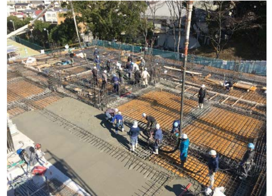
コンクリート打設状況（1/11撮影）
