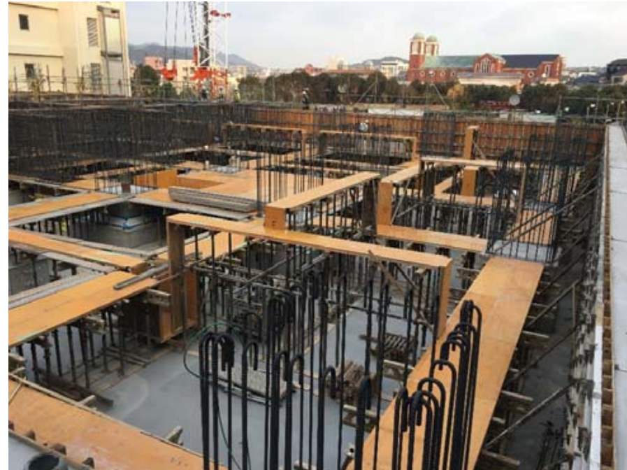
1階床梁型枠施工状況（12/16撮影）
