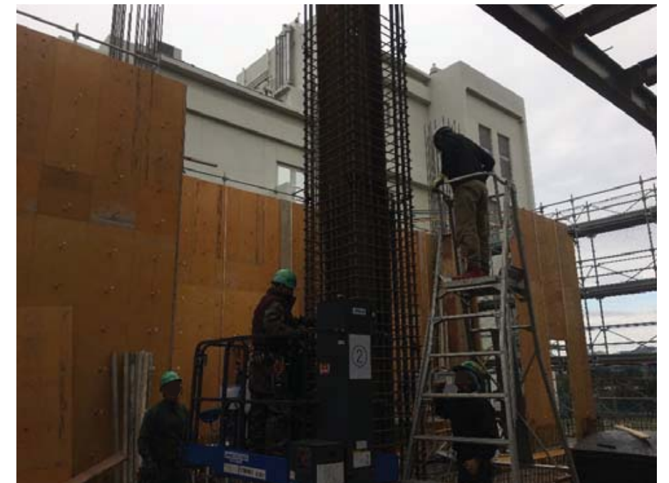
1階柱鉄筋組立状況（1/24撮影）
