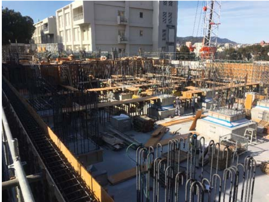
型枠工事施工状況（12/14撮影）
