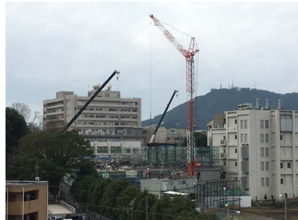
施工状況全景（1/24撮影）
