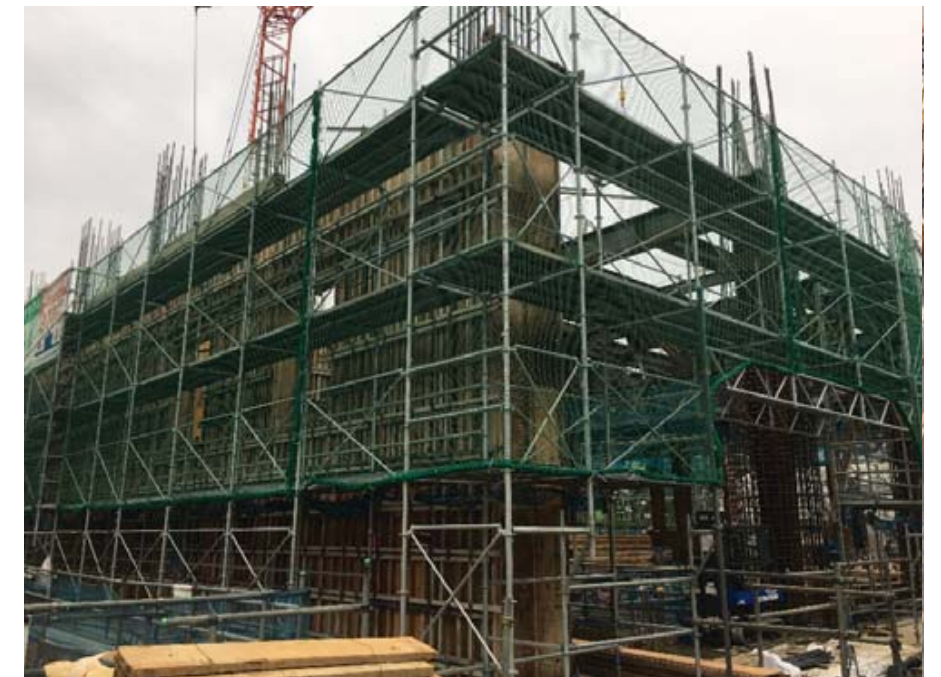
1階壁型枠施工状況（1/25撮影）
