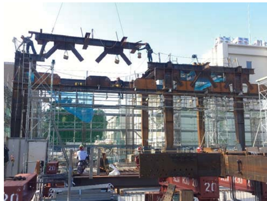
鉄骨工事施工状況（1/24撮影）
