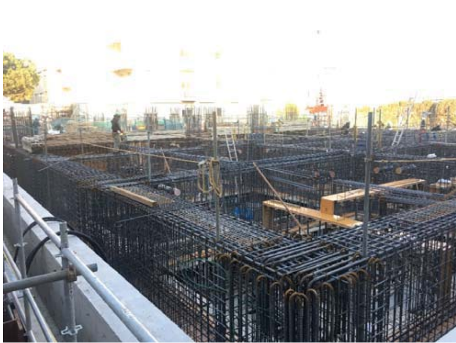
鉄筋工事施工状況（12/24撮影）
