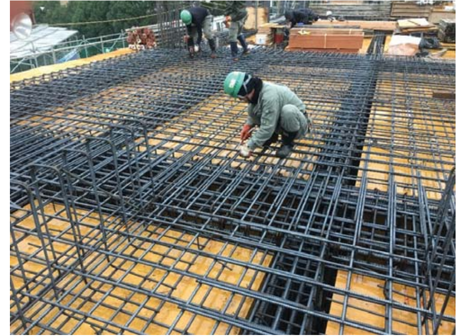
1階床スラブ鉄筋組立状況（12/25撮影）
