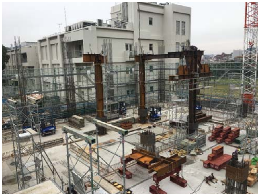
鉄骨工事施工状況（1/16撮影）
