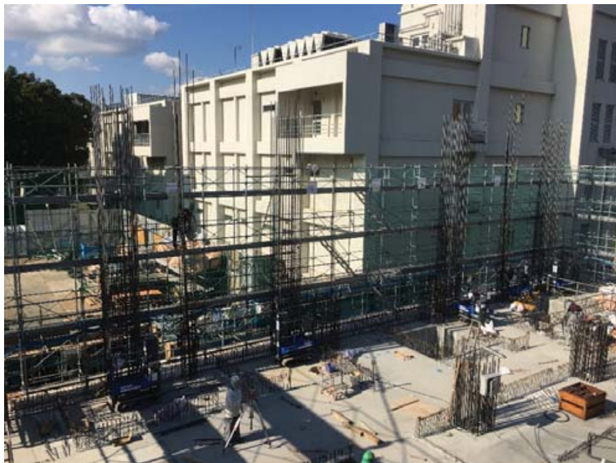
鉄筋工事施工状況（1/11撮影）
