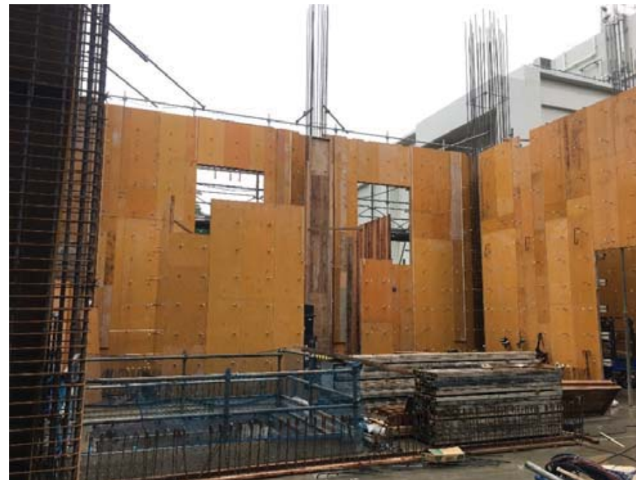
1階壁型枠施工状況（1/24撮影）
