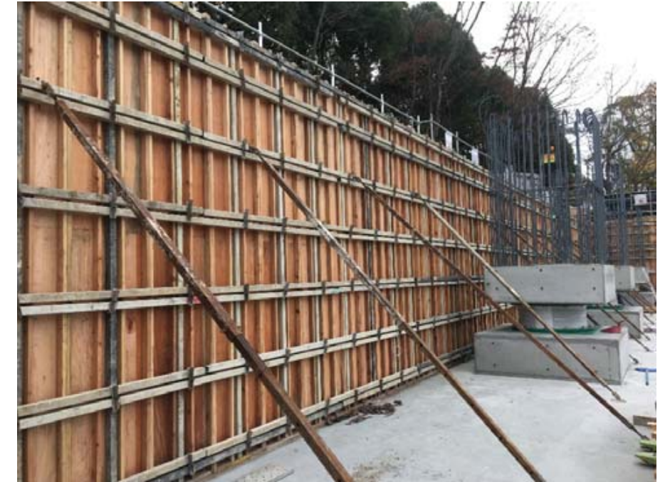
よう壁型枠施工状況（12/11撮影）
