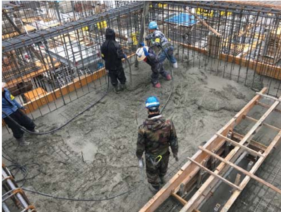
コンクリート打設状況（12/3撮影）
