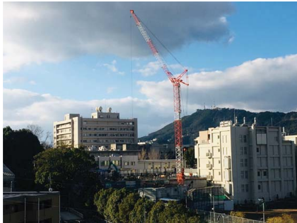
施工状況全景（12/27撮影）
