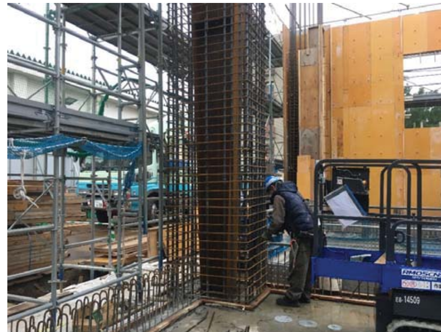
1階柱鉄筋組立状況（1/24撮影）
