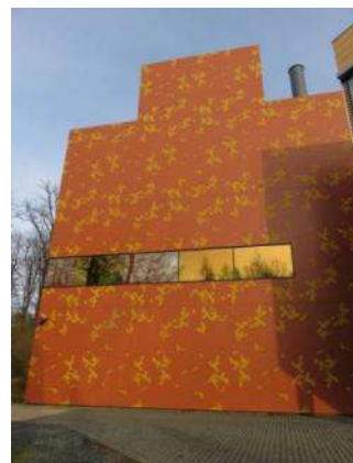
② BSL-4施設の外観
