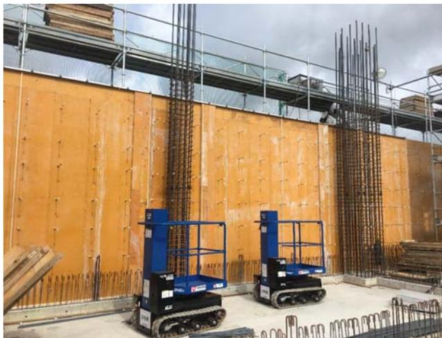
4階壁型枠施工状況（7/25撮影）
