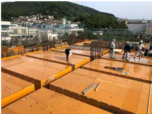
4階床スラブ型枠施工状況（7/8撮影）
