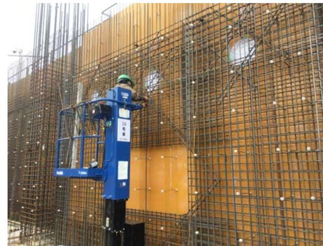
4階壁鉄筋組立状況（7/25撮影）
