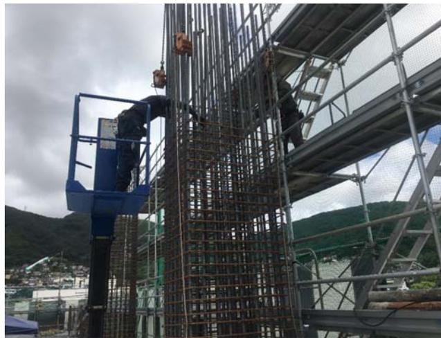
4階柱鉄筋組立状況（7/20撮影）
