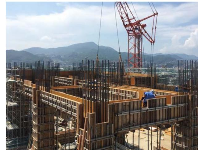
5階梁型枠施工状況（7/30撮影）
