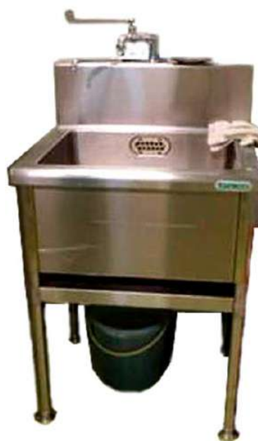
写真③（排水設備のない流し台）
