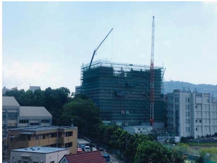
施工状況全景（8/31撮影）
