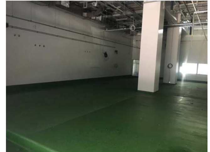
内装工事施工状況（9/9撮影）
