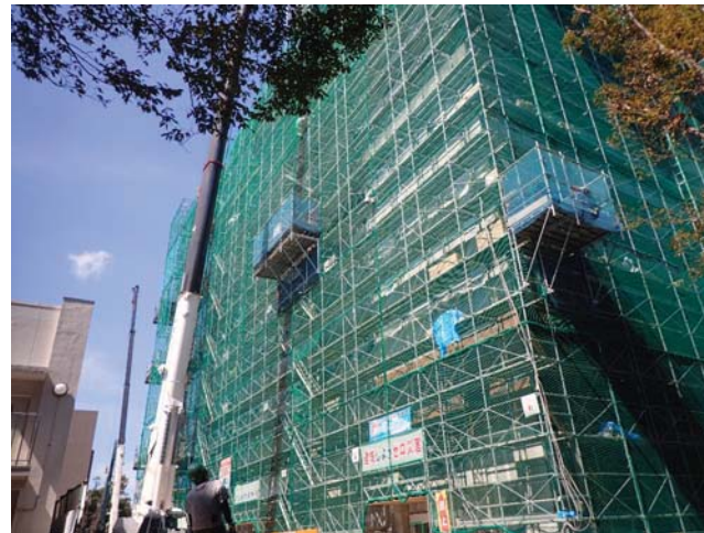
仮設足場組立状況（9/29撮影）
