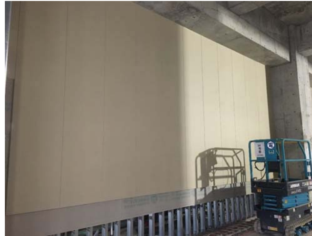
内装工事施工状況（9/4撮影）
