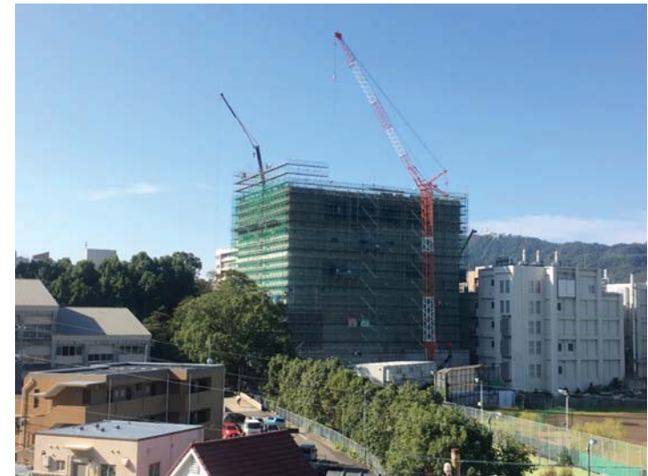
施工状況全景（9/29撮影）
