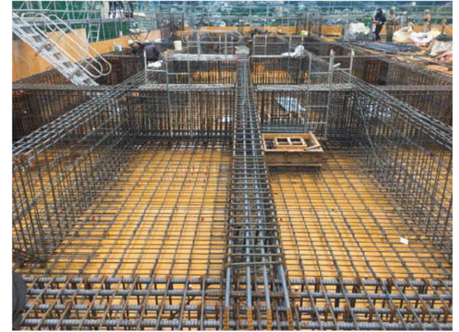
屋上階梁鉄筋組立状況（9/19撮影）
