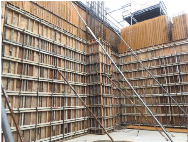
5階壁型枠施工状況（9/4撮影）
