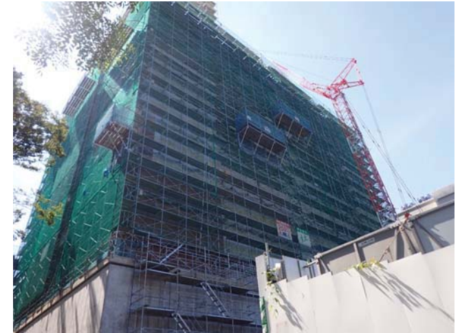
仮設足場組立状況（9/29撮影）
