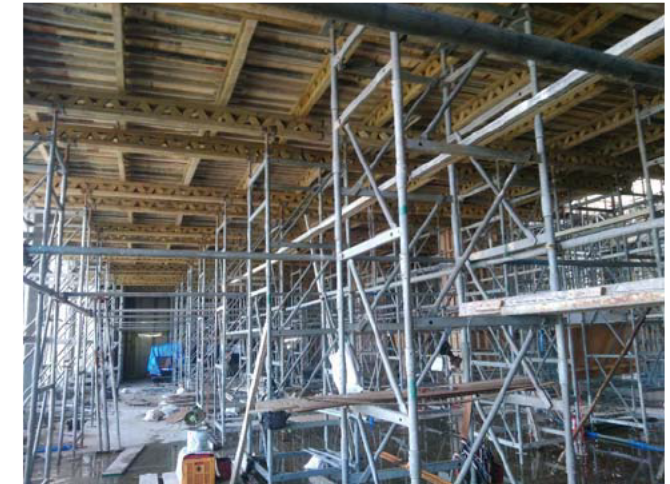
屋上階床スラブ型枠施工状況（9/25撮影）
