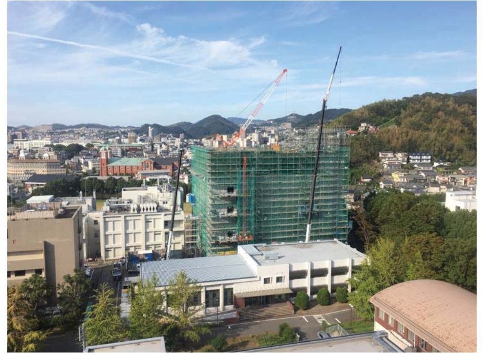
施工状況全景（9/29撮影）
