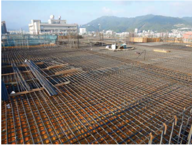
5階床スラブ鉄筋組立状況（8/17撮影）
