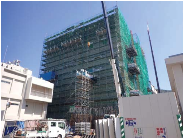
仮設足場組立状況（9/29撮影）
