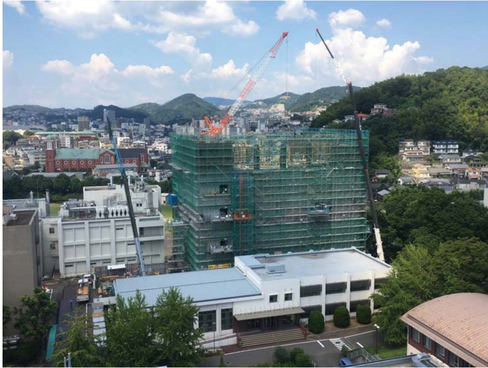
施工状況全景（8/31撮影）
