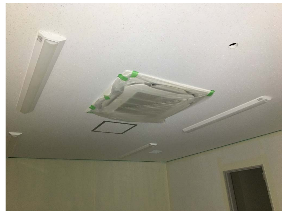
設備工事施工状況（10/29撮影）
