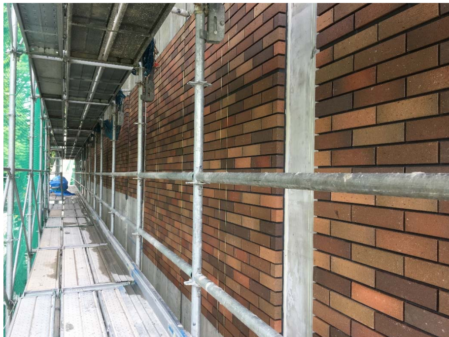
外壁工事施工状況（11/5撮影）
