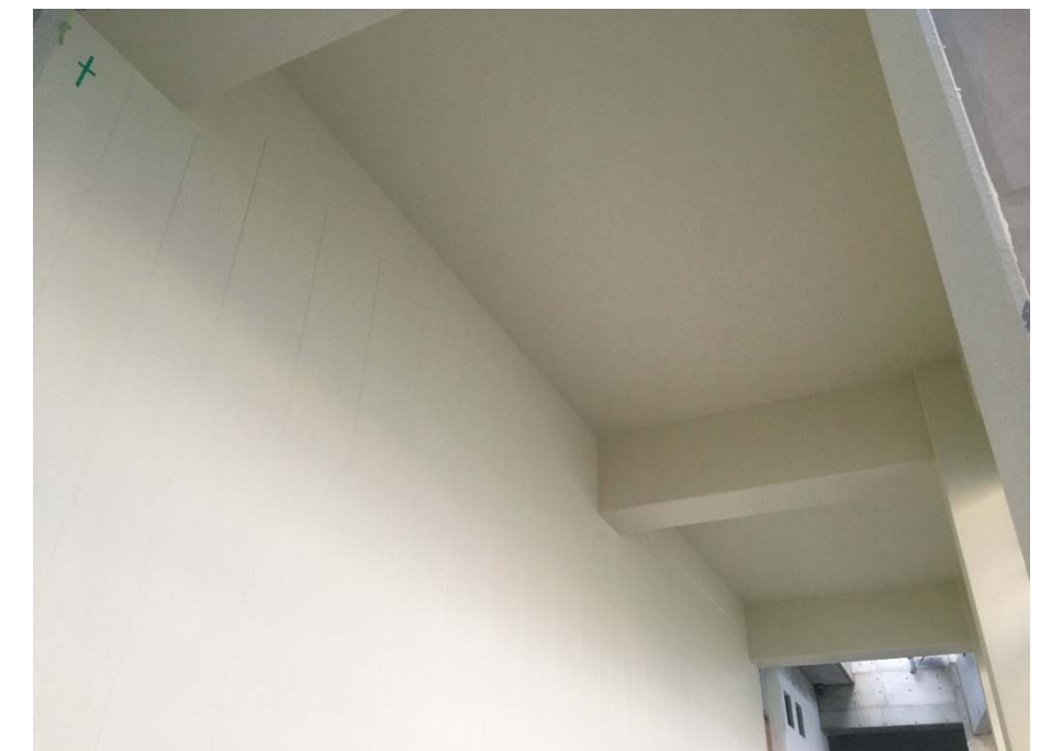
外壁工事施工状況（11/25撮影）
