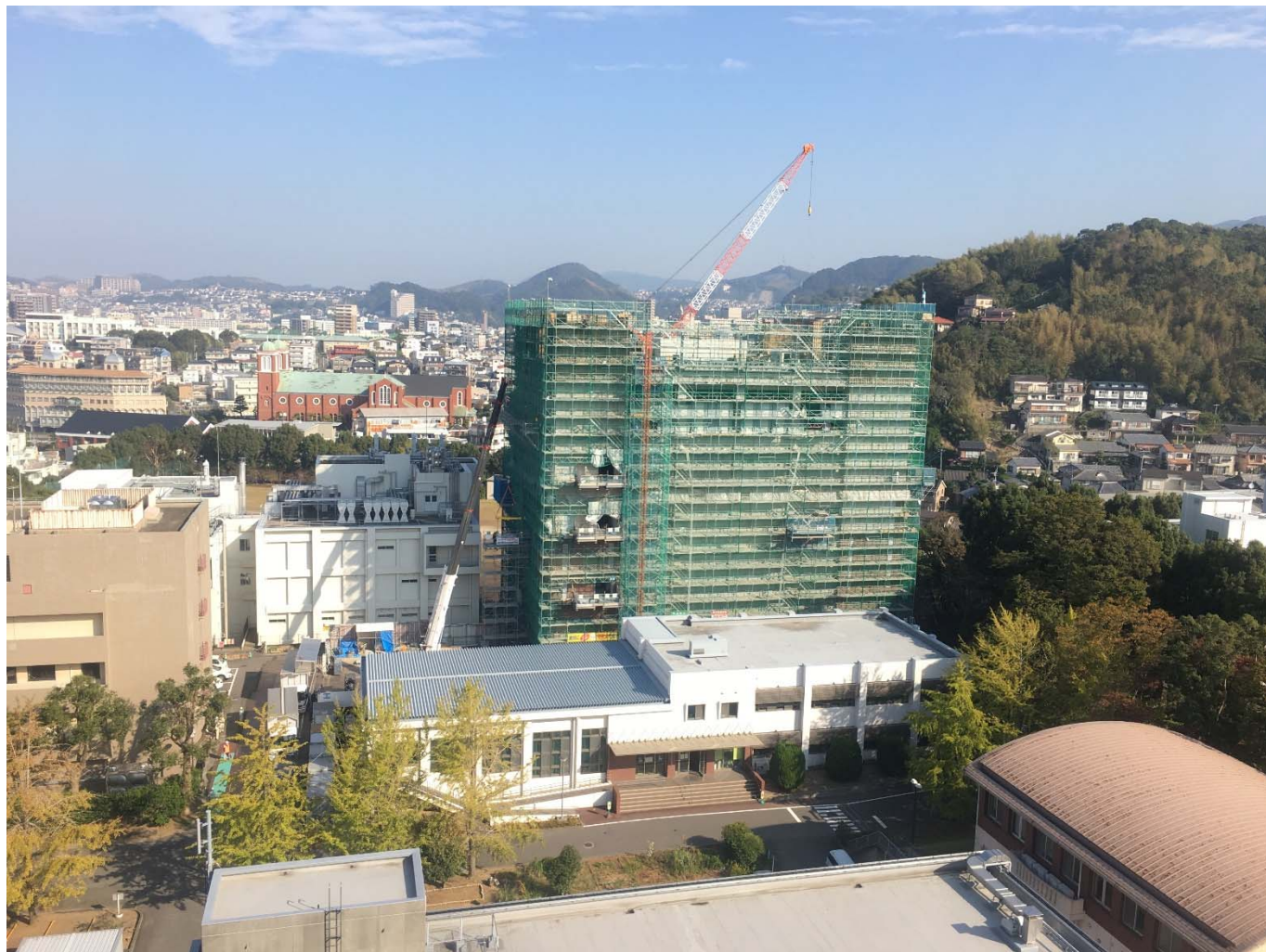
施工状況全景（10/29撮影）
