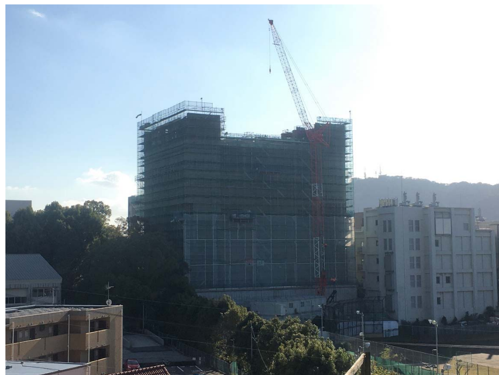
施工状況全景（11/3撮影）
