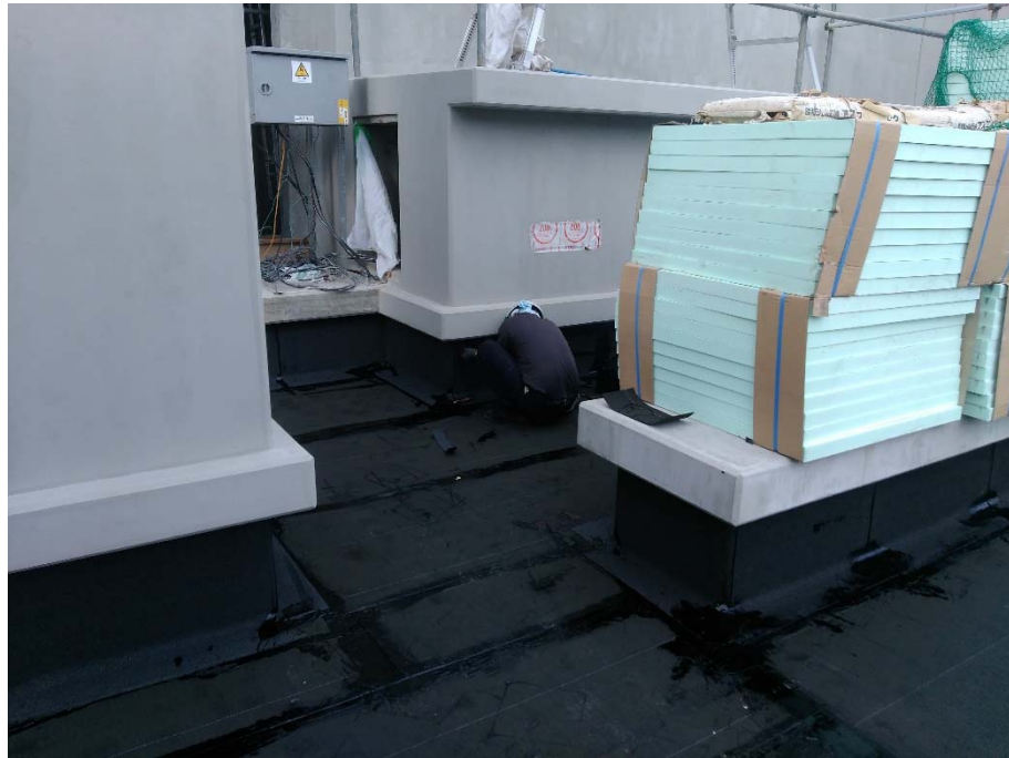
防水工事施工状況（11/27撮影）
