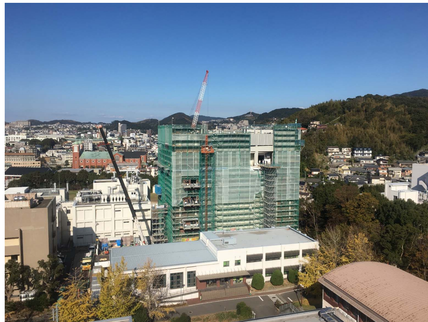
施工状況全景（12/2撮影）
