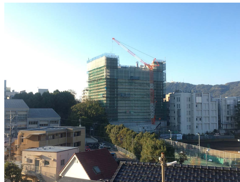
施工状況全景（12/2撮影）
