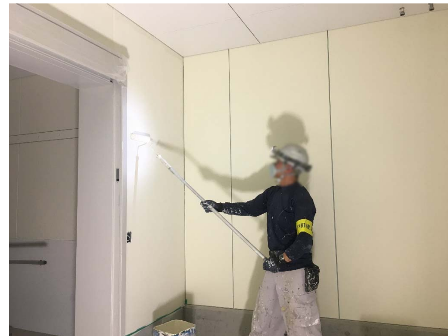
内装工事施工状況（10/20撮影）
