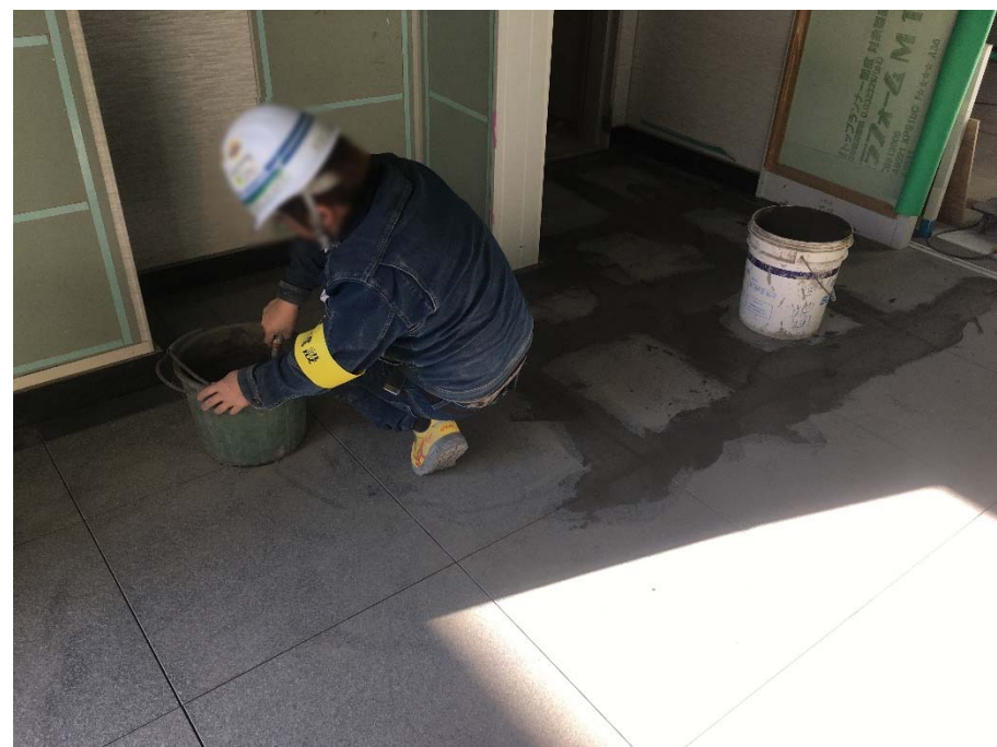
内装工事施工状況（11/30撮影）
