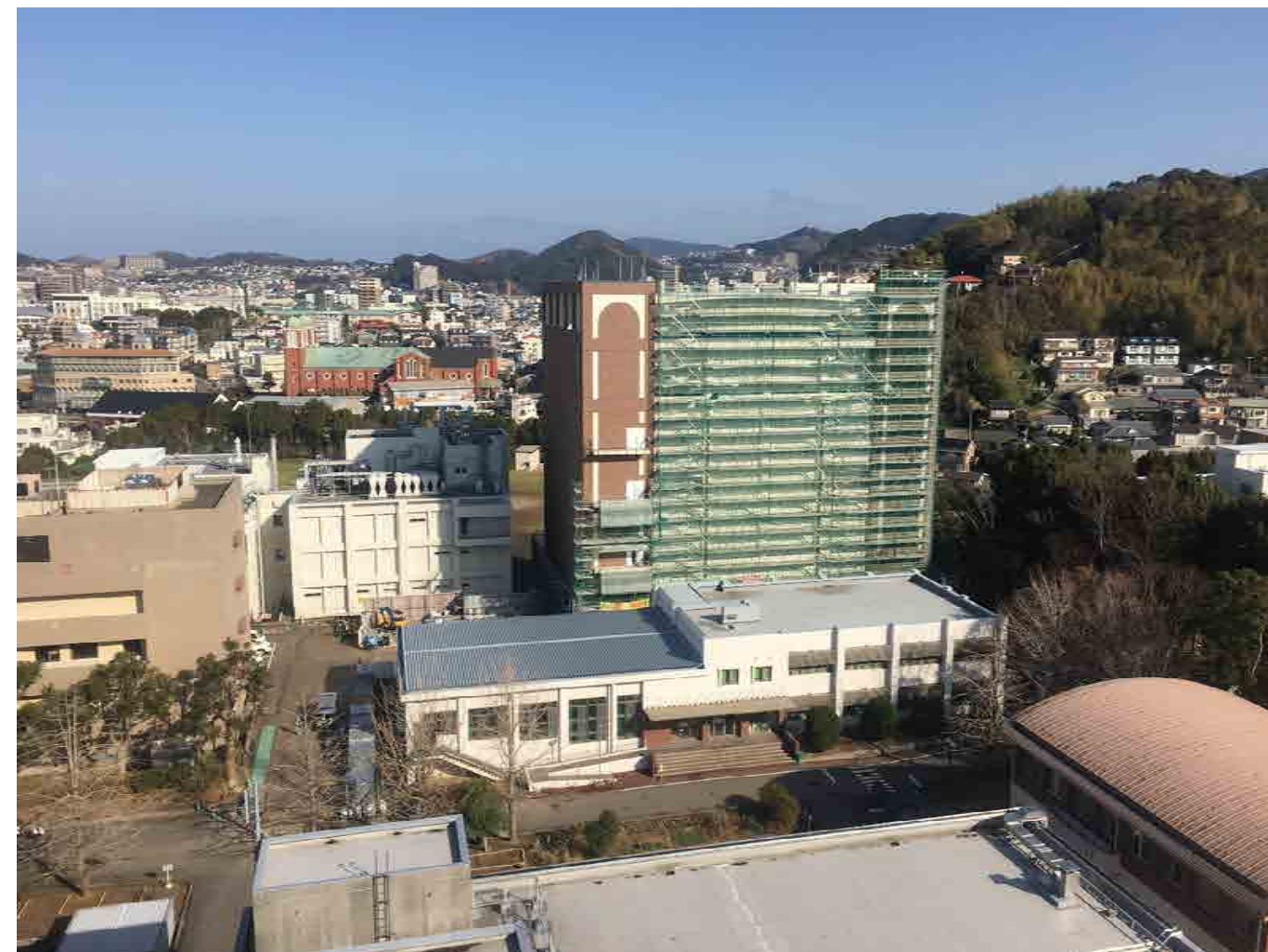
施工状況全景（1/29撮影）
