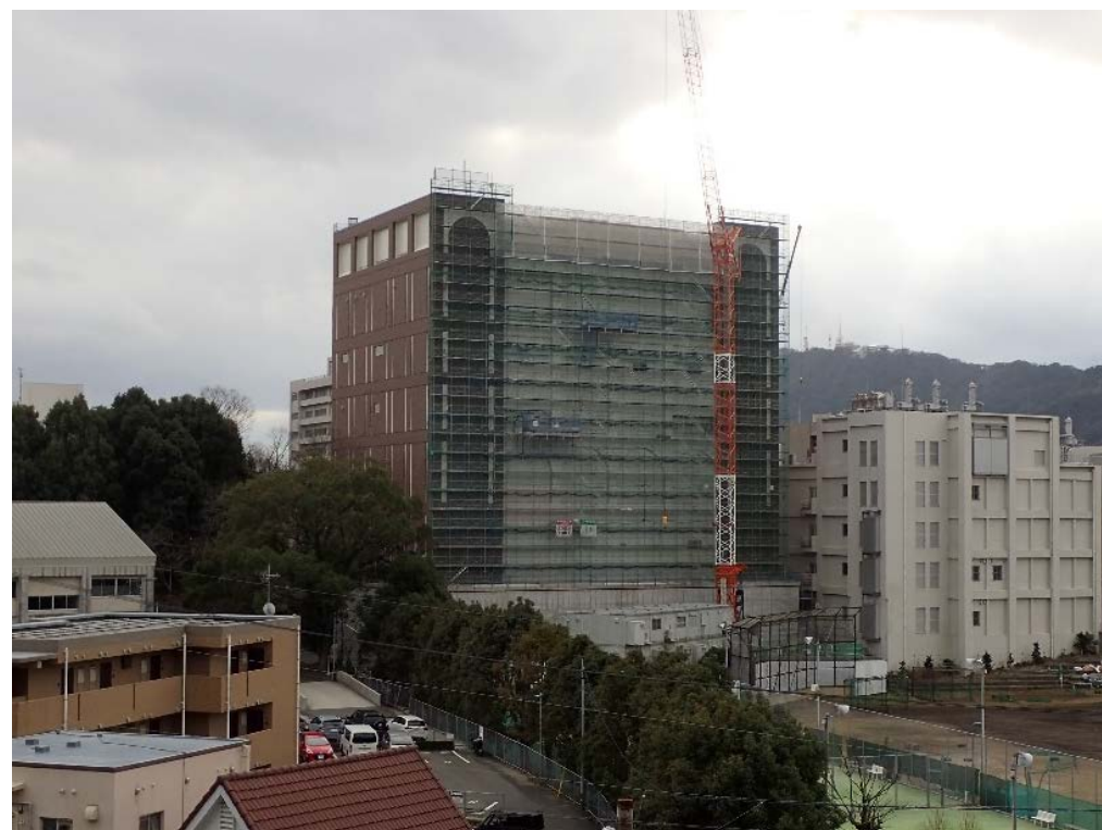
施工状況全景（1/6撮影）
