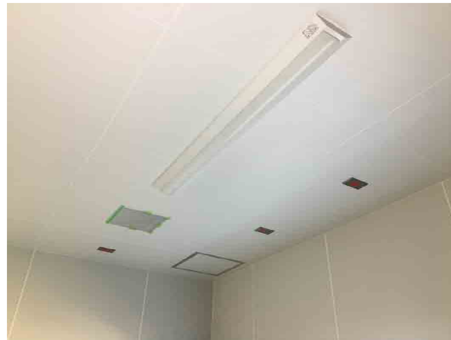
設備工事施工状況（1/21撮影）
