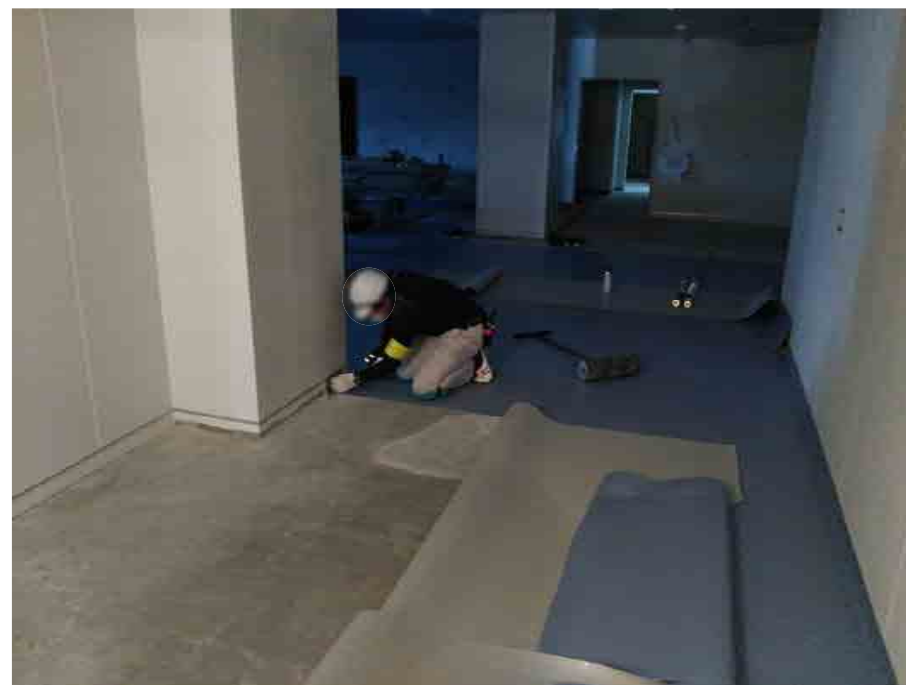
内装工事施工状況（1/26撮影）
