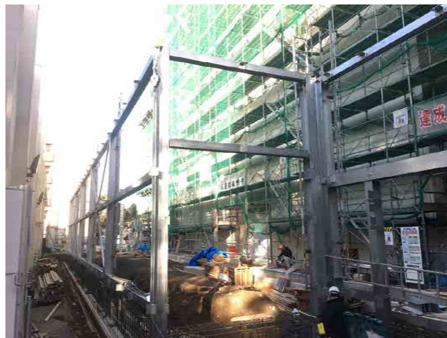
外構工事施工状況（1/25撮影）
