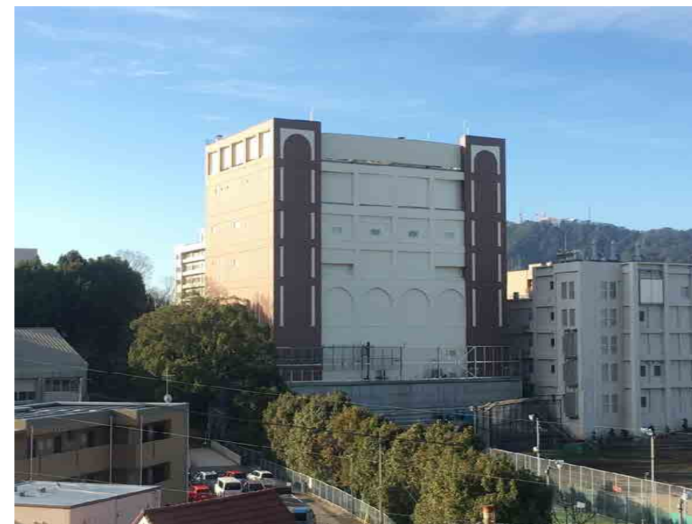
施工状況全景（1/26撮影）
