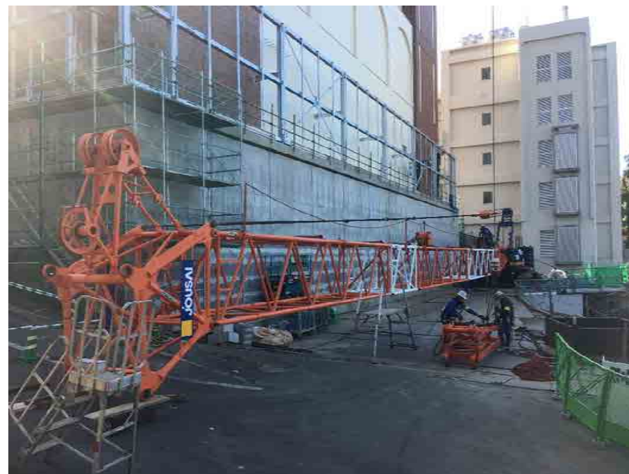
クレーン解体施工状況（1/20撮影）
