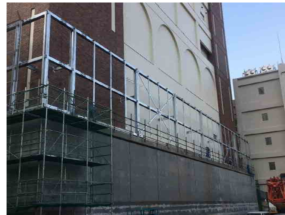
外構工事施工状況（1/21撮影）
