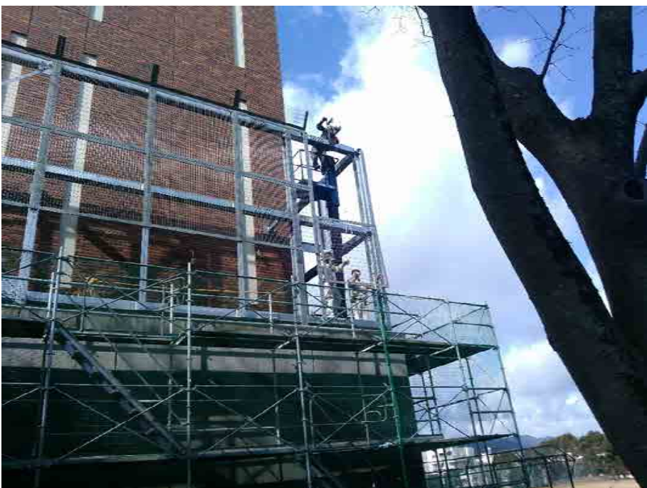
外構工事施工状況（1/22撮影）
