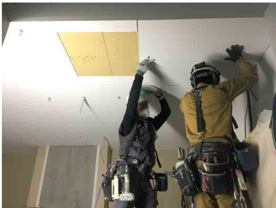
内装工事施工状況（1/27撮影）
