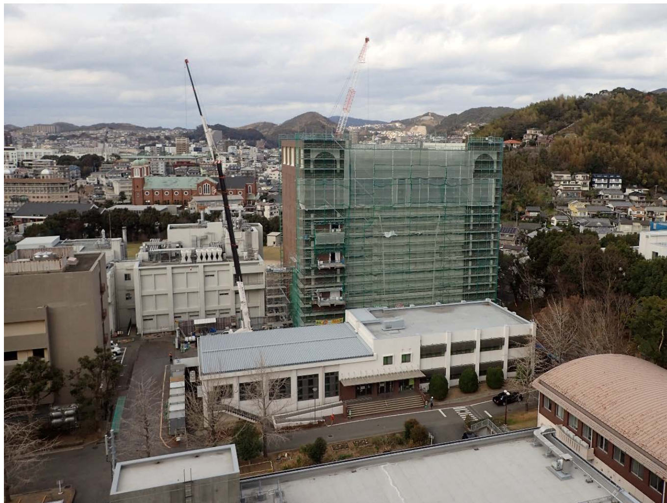
施工状況全景（1/6撮影）
