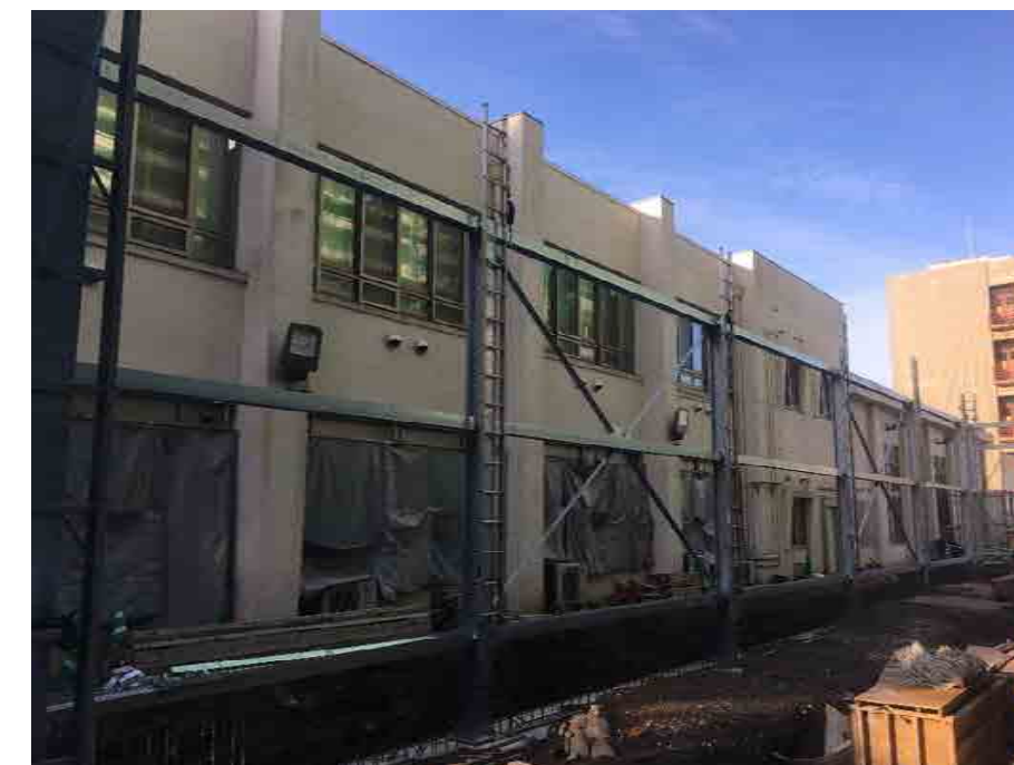
外構工事施工状況（1/25撮影）
