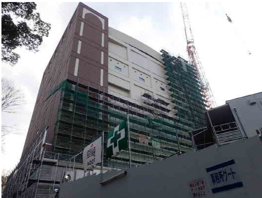
足場解体施工状況（1/12撮影）
