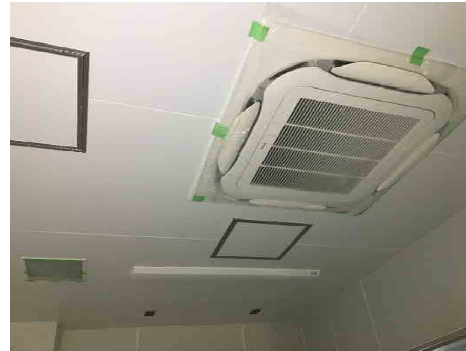
設備工事施工状況（1/21撮影）
