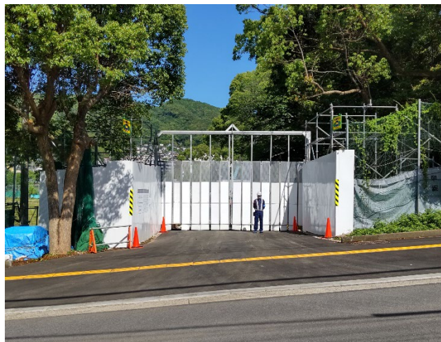
工所用ゲート設置状況 (5/19撮影)
