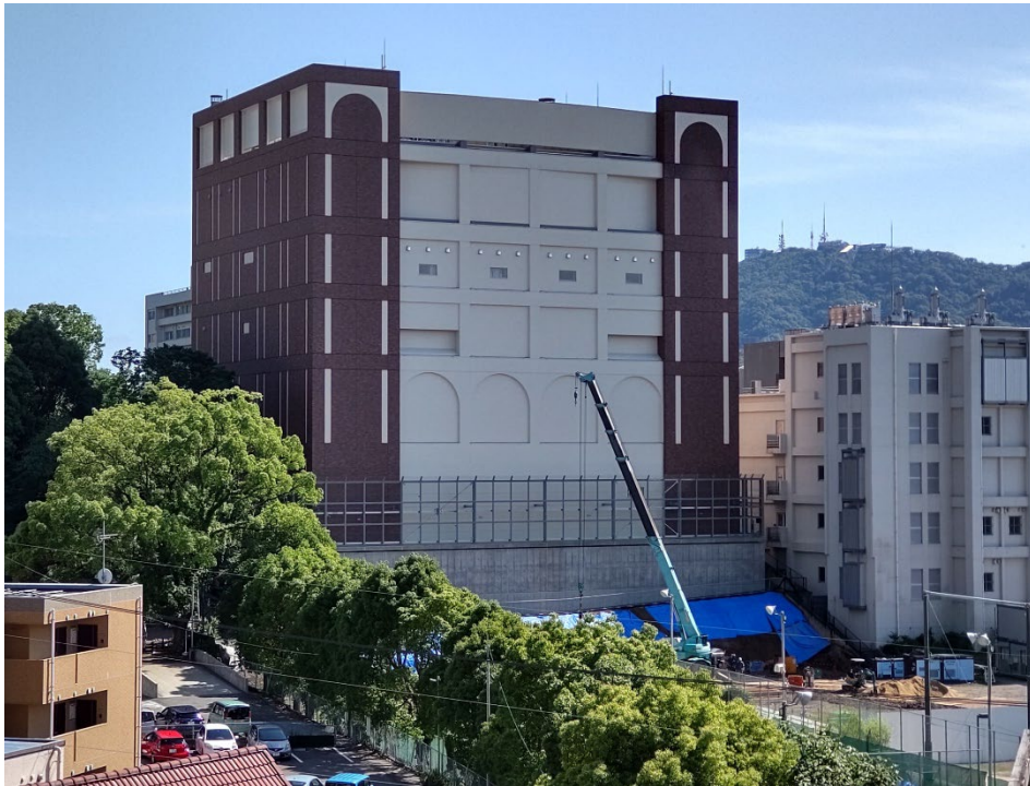
施工状況全景 (5/19撮影)
