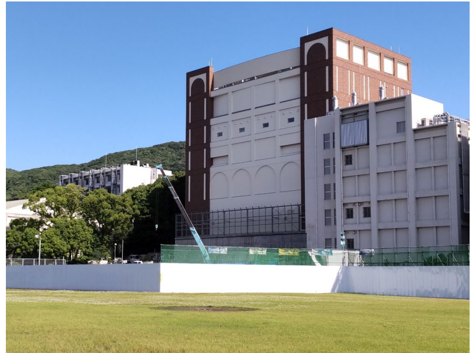
施工状況全景 (5/19撮影)
