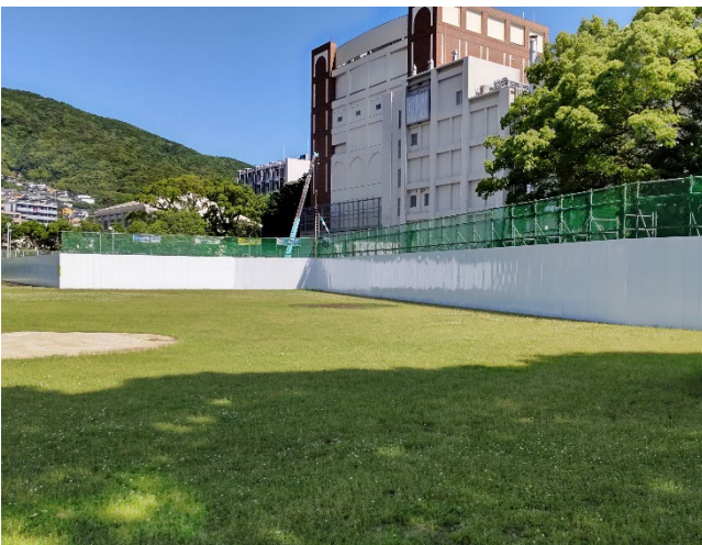
工所用仮囲設置状況 (5/19撮影)
