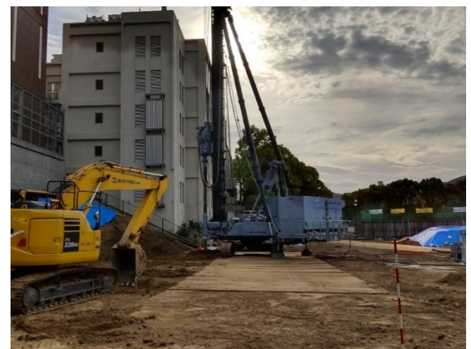
地盤改良工事施工状況 (4/23)
