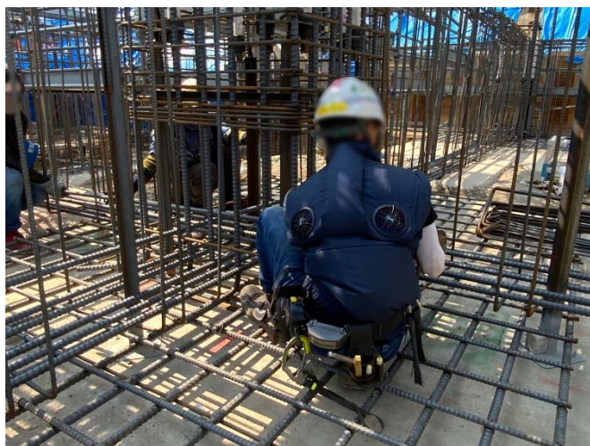
基礎工事施工状況 (6/23撮影)
