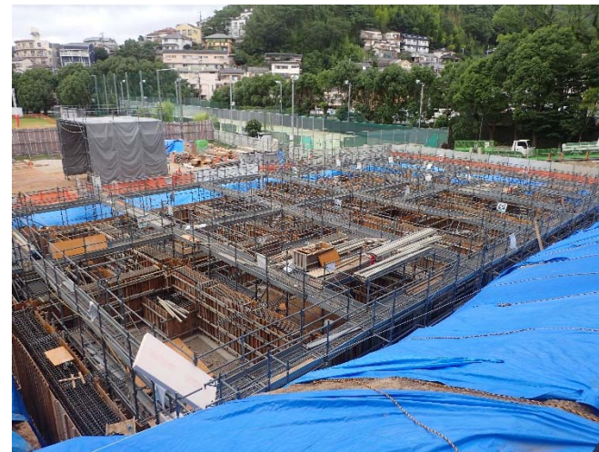
基礎工事施工状況 (7/6)
