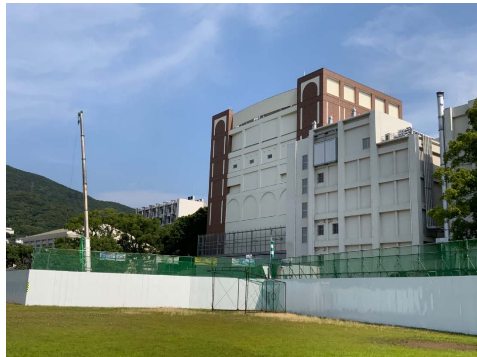
施工状況全景 (6/25撮影)
