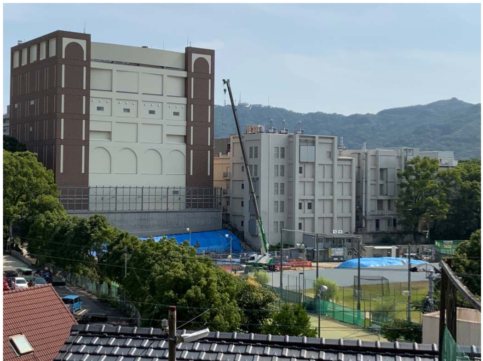
施工状況全景 (6/25撮影)
