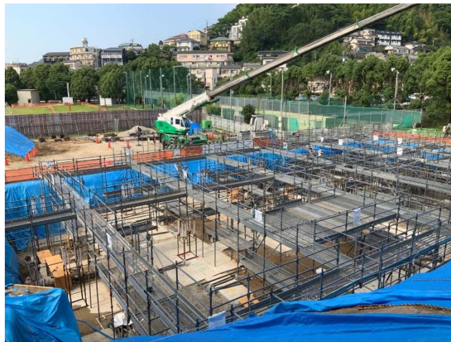
基礎工事施工状況 (6/25撮影)
