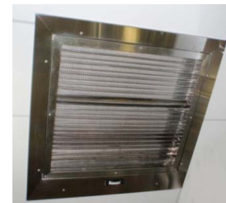
換気口部分の侵入防止対策
