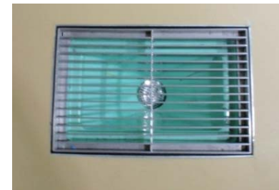
排水口部分の侵入防止対策
