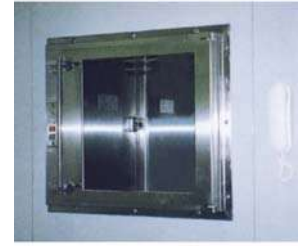
パスボックスの写真
