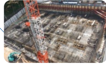
2019年10月 基礎工事
