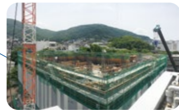
2020年5月 2階鉄筋・型枠工事
