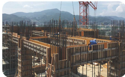
2020年7月 3階鉄筋・型枠工事
