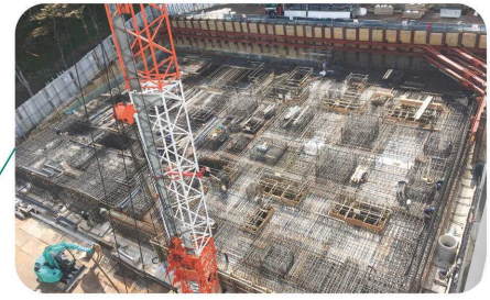
2019年10月 基礎工事
