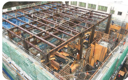
2020年1月 1階鉄骨工事
