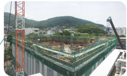
2020年5月 2階鉄筋・型枠工事
