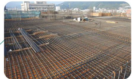
2020年8月 4階鉄筋・型枠工事
