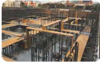
2019年12月 鉄筋・型枠工事
