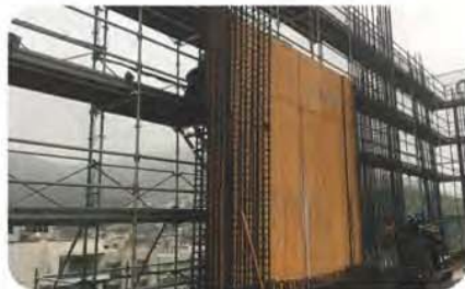
2020年8月 鉄筋・型枠工事
