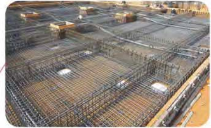
2020年4月 鉄筋・型枠工事
