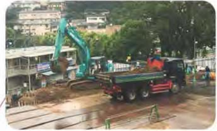
2019年8月 土工事 地表面より下の構造をつくるため、土を掘って別の場所に搬出する作業を行っています。
