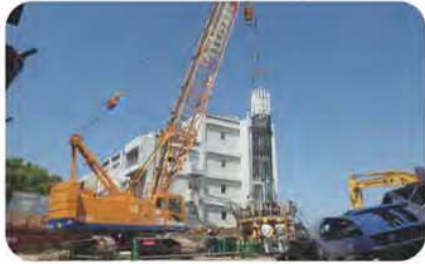
2019年4月 杭工事 建物を支える杭を造っています。
