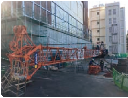
クレーン解体
